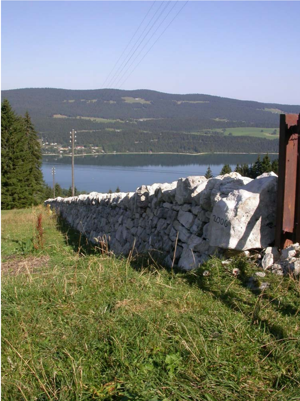
Un mur de pâturage refait à neuf du côté d'en bas entre la Pièce à Ferdinand et la pièce à Neveu. C'est ce qui s'appelle de la belle ouvrage.
